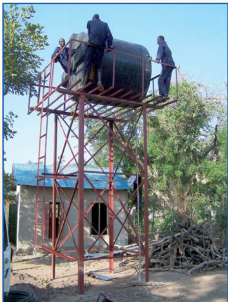
Fixierung des 5000 Liter Wassertanks auf einem 5 m hohen Tankständer
