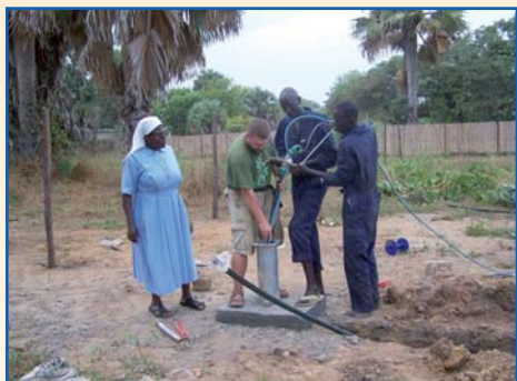
Fixierung der versenkbaren Solar Wasserpumpe in dem 60m tiefen Bohrloch
