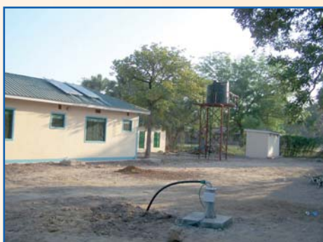
Das komplette System: Bohrloch, Wassertank, Solaranlage für die Wasserpumpe auf dem Dach
